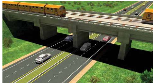
สะพานรถไฟข้ามทางรถยนต์ (Underpass) ในกรณีที่เป็นถนนสายหลัก มีปริมาณการจราจรหนาแน่น
