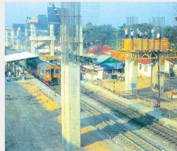
การก่อสร้างโครงการรถไฟฟ้าไฮโวลต์ ตามแนวเส้นทางรถไฟเดิมของการรถไฟฯ
