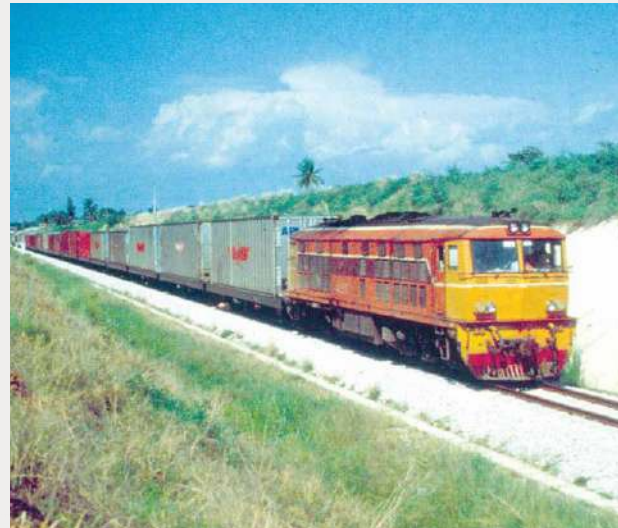
เส้นทางรถไฟสายศรีราชา - แหลมฉบัง เปิดให้บริการเมื่อวันที่ 22 ตุลาคม พ.ศ. 2536
