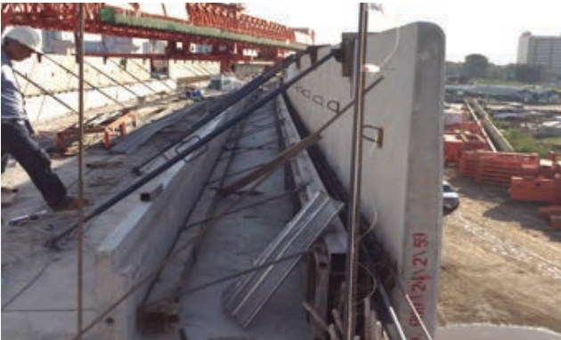
รูปที่ 3 งานติดตั้งแผ่นกันตกรสำเร็จของโครงสร้างทางวิ่งยกระดับ
