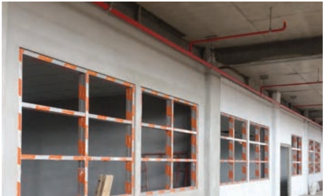
รูปที่ 11 งานติดตั้งประตูหน้าต่าง บริเวณอาคาร LD-Passenger Coach
