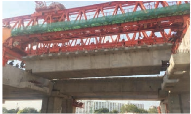
รูปที่ 2 งานติดตั้งชิ้นส่วนสำเร็จรูปของโครงสร้างทางวิ่งยกระดับ
