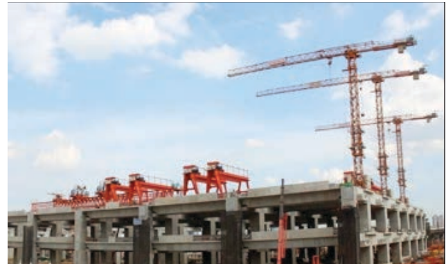
รูปที่ 4 ความก้าวหน้าโดยรวมบริเวณสถานีกลางบางซื่อ
