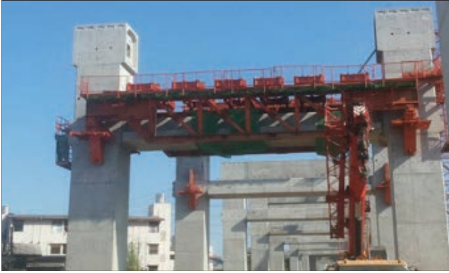
รูปที่ 7 งานติดตั้งแผ่นกันตกรสำเร็จบริเวณสถานีกลางบางซื่อ
