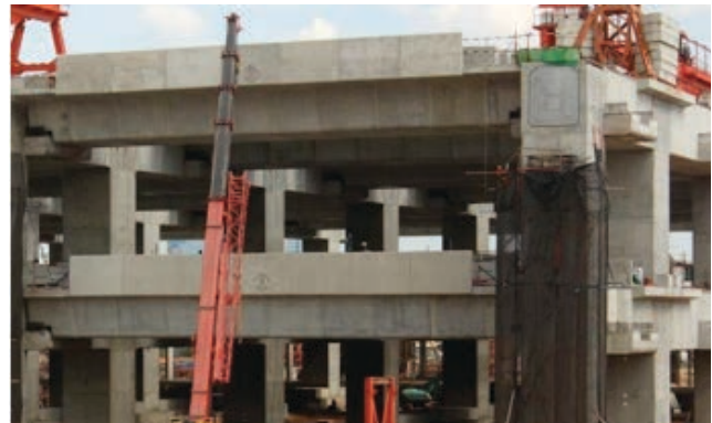
รูปที่ 6 งานเทพื้นคอนกรีตบริเวณสถานีกลางบางซื่อ
