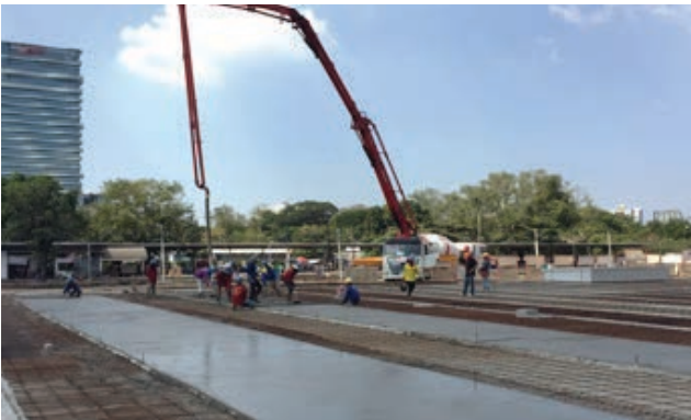
รูปที่ 5 ความก้าวหน้าโดยรวมบริเวณสถานีกลางบางซื่อ
