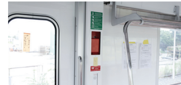
ระบบเปิดประตูฉุกเฉิน
