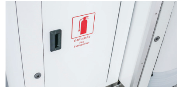
ถังดับเพลิง
