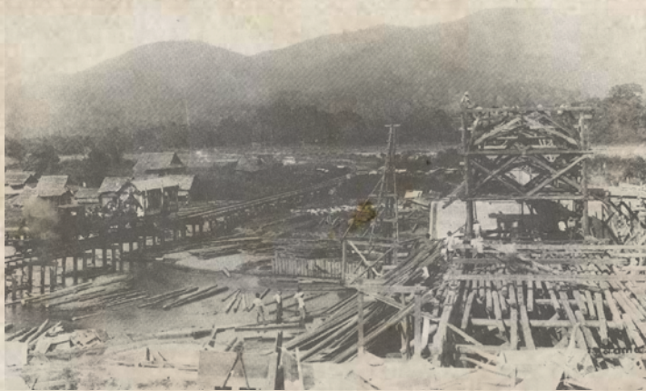
สะพานทามกู่ในระหว่างการก่อสร้าง
