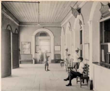
ที่ทำการไปรษณีย์โทรเลขที่ 1 บริเวณสะพานปฐมบรมราชานุสรณ์
