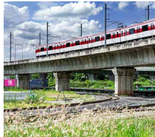
เครดิตภาพ : Teppakorn Tongboonto สถานที่ : โรงกลิ้งล้อโรงรถจักรดีเซลบางซื่อ ทางแยกสายใต้ สายเหนือ
