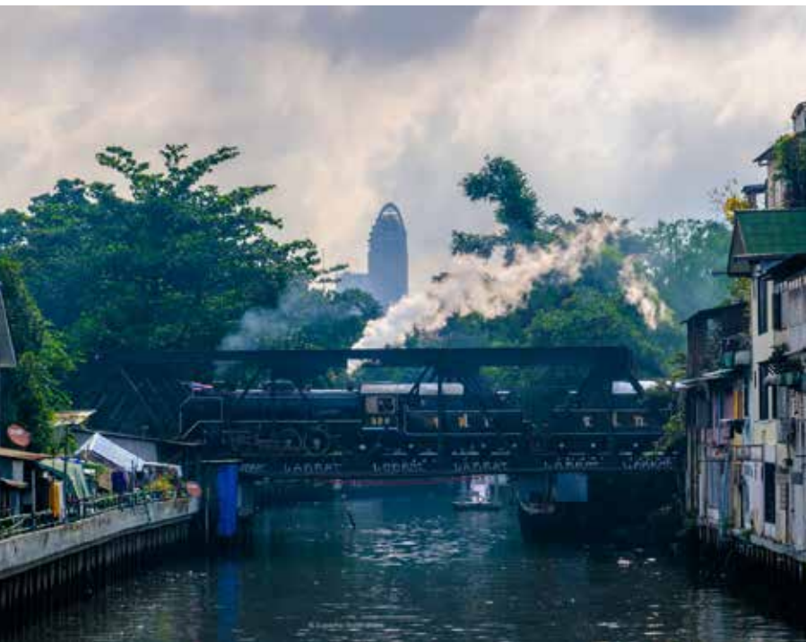
เครดิตภาพ : Supachai Rohitrattana สถานที่ : สะพานรถไฟข้ามคลองย่านโบ๊เบ๊ กรุงเทพฯ
