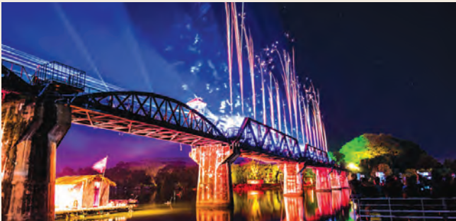
งานลีปตาห้สะพานข้ามแม่น้ำแคว เป็นหนึ่งในการท่องเที่ยวที่ทำให้ประชาชนทั่วไปรู้จักรถไฟมากขึ้น
